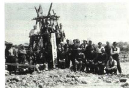
校舎新築工事始まる(昭25・6)
