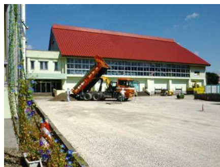
【駐車場舗装工事】
