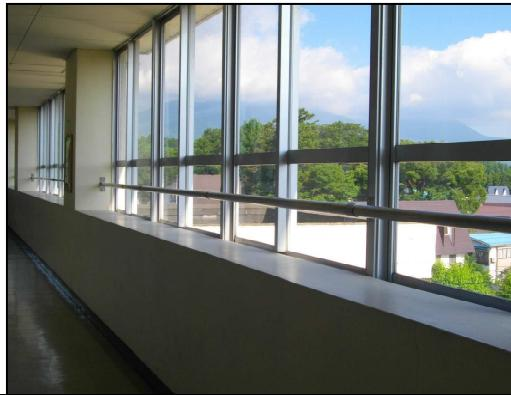
3、4階の廊下の窓に、落下防止の手すりが設置されました。7月26日には、2階の窓にも設置され、すべての廊下に設置完了となります。
