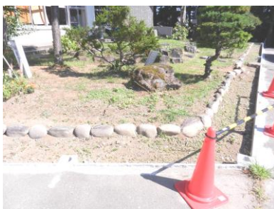
花壇のコンクリート枠設置
